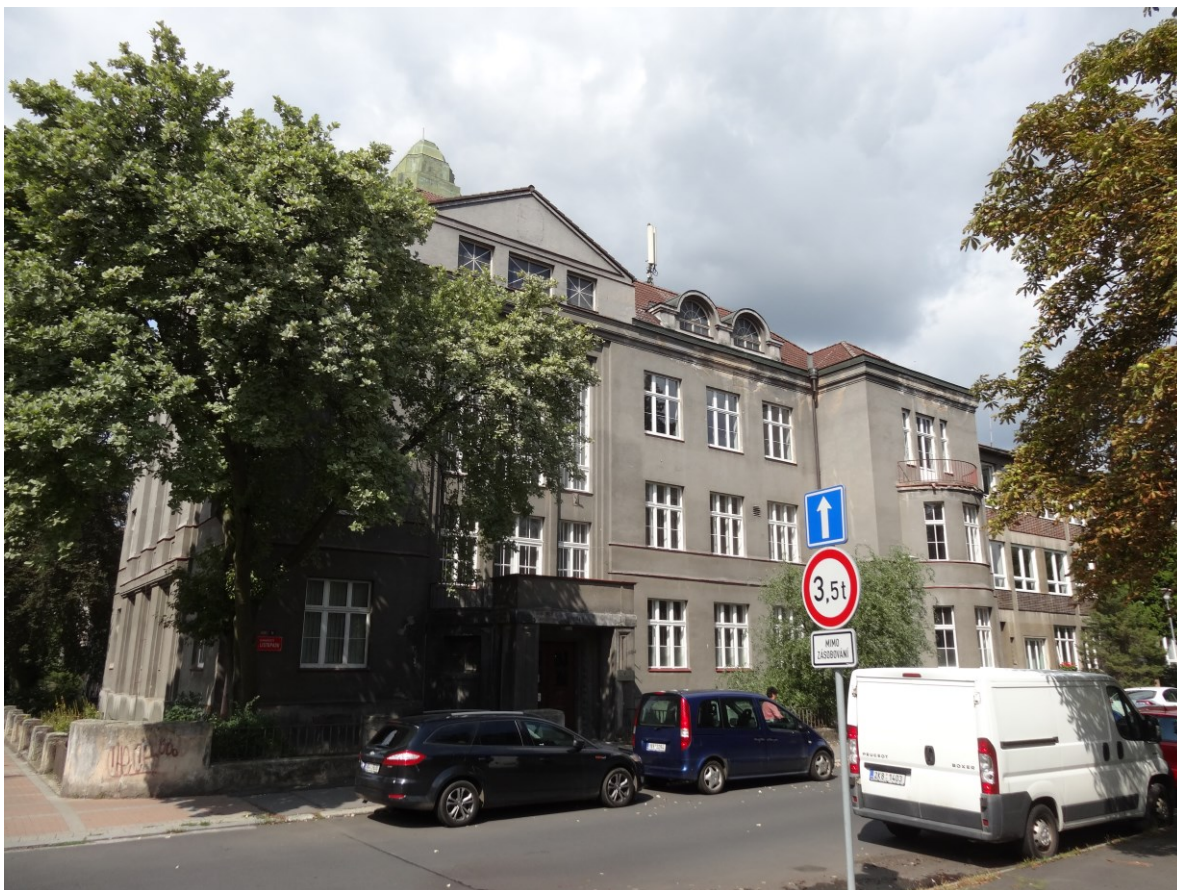
Budova školy - Pohled od jihovýchodu
