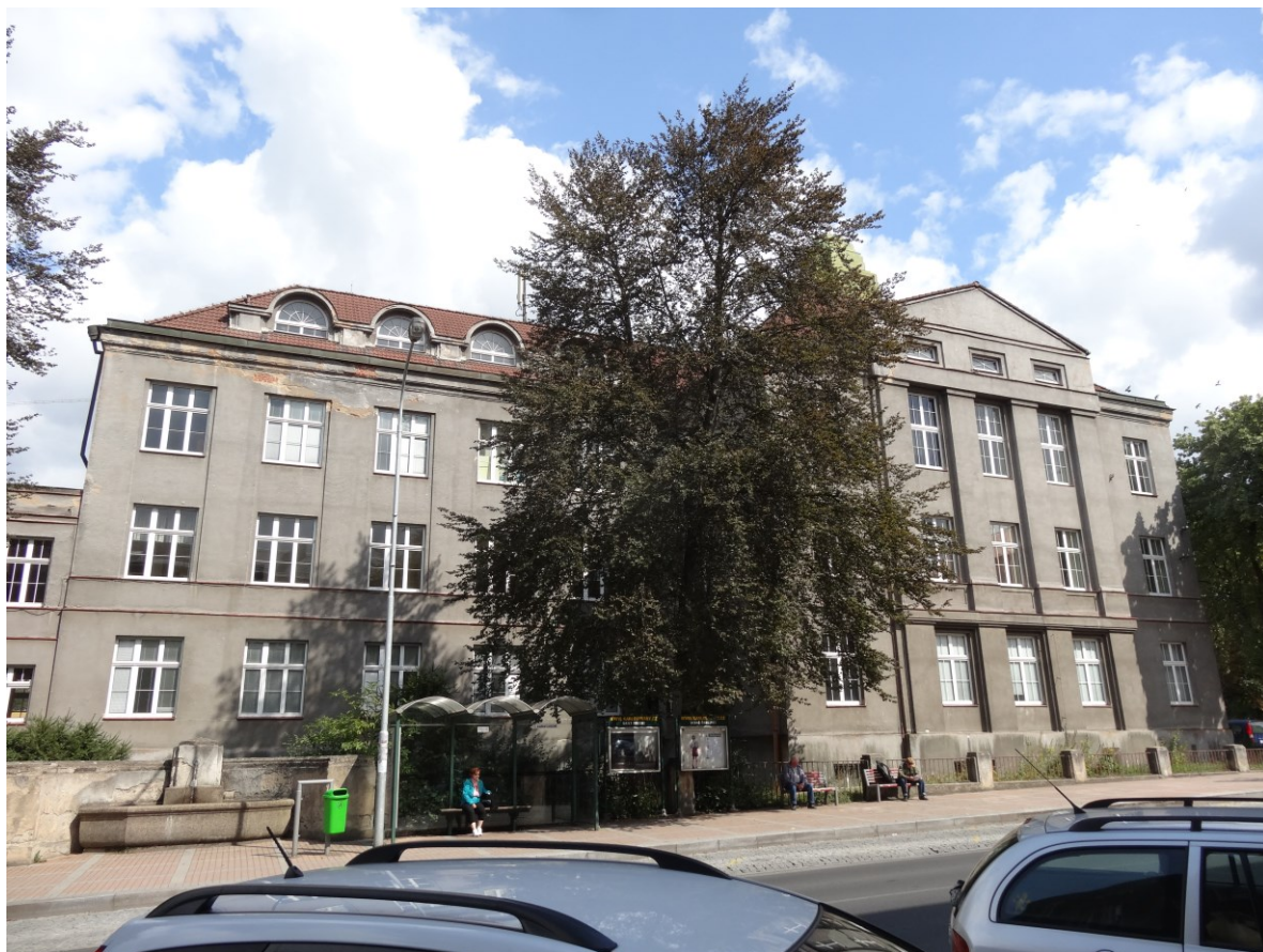
Budova školy - Pohled od jihozápadu
