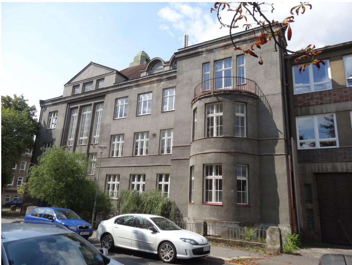
Budova školy - Pohled od severovýchodu
