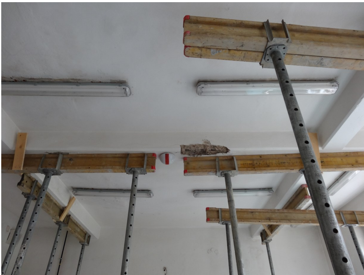
Strop učebny pod chemickou třídou
