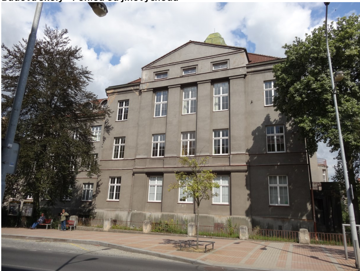
Budova školy - Pohled od jihu
