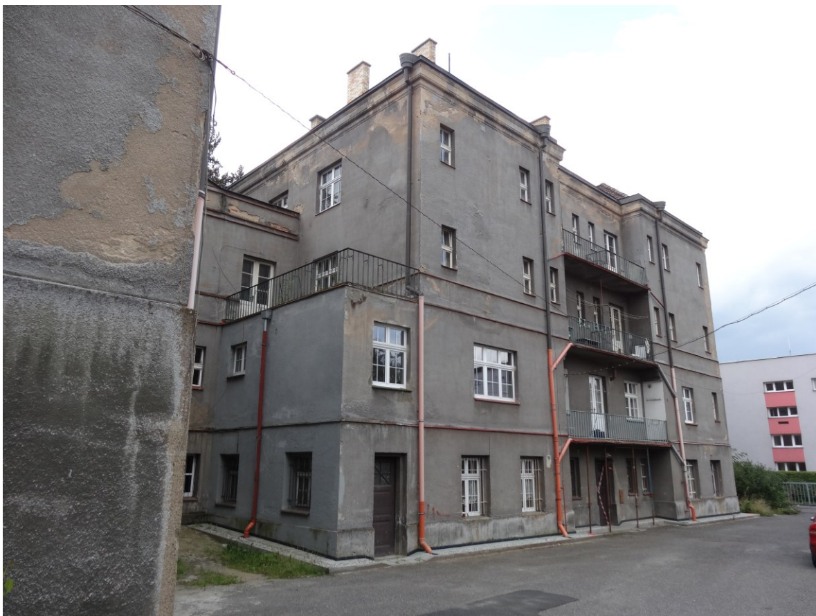
Budova bytového domu - Pohled od severovýchodu
