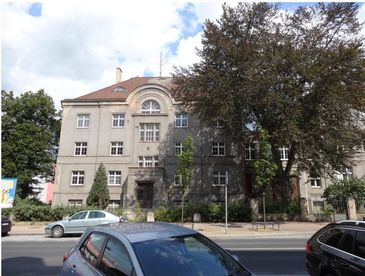
Budova bytového domu - Pohled od jihu
