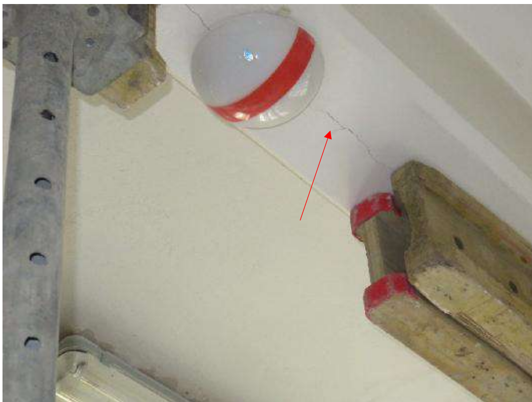
Foto 12: Hlavní budova 1.NP, místnost M2: trhлина na spodním líci středu tránu cca 3 až 4 mm.
