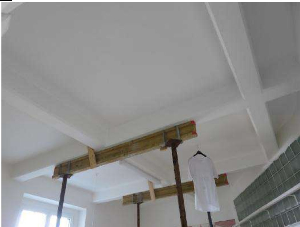
Foto 33: Hlavní budova 3.NP, místnost M3: viditelný průhyb stropní konstrukce cca 20 až 30 mm.
