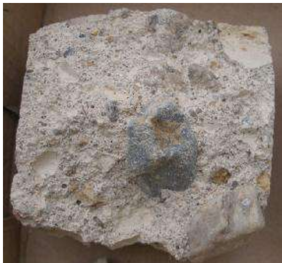
Foto 1: Vzorek betonu V 0.4
