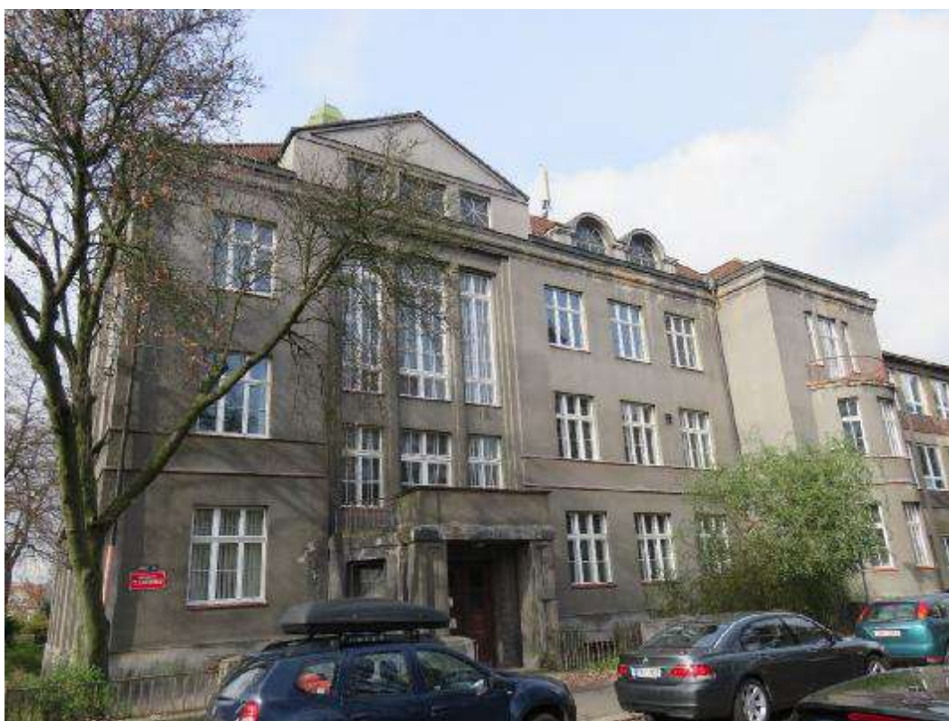
Foto 6: Východní strana: pohled na východní fasádu, na fasádě jsou patrné stopy po zatékání, degradace omítek zejména v oblasti atik.
