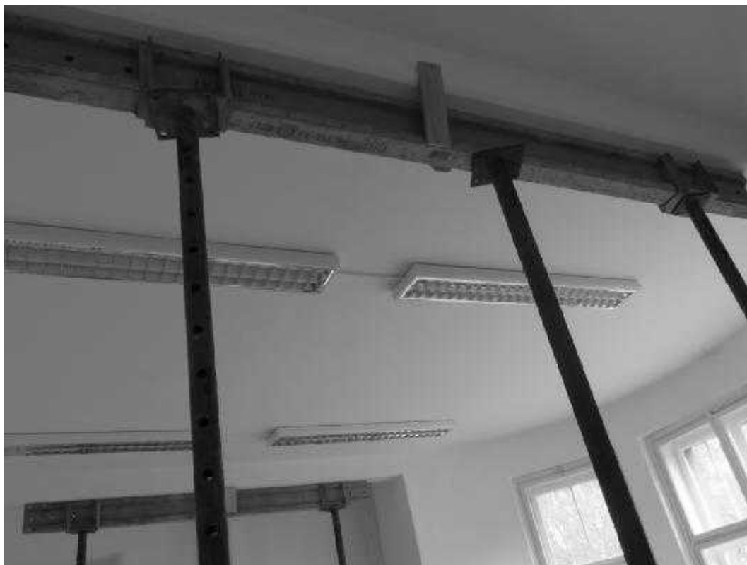
Foto 27: Hlavní budova 2.NP, místnost M2: viditelný průhyb stropní konstrukce cca 20 až 30 mm.
