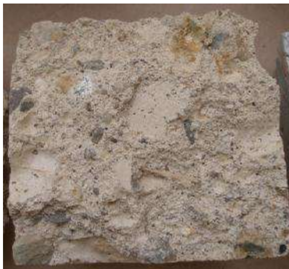
Foto 3: Vzorek betonu V 1.4
