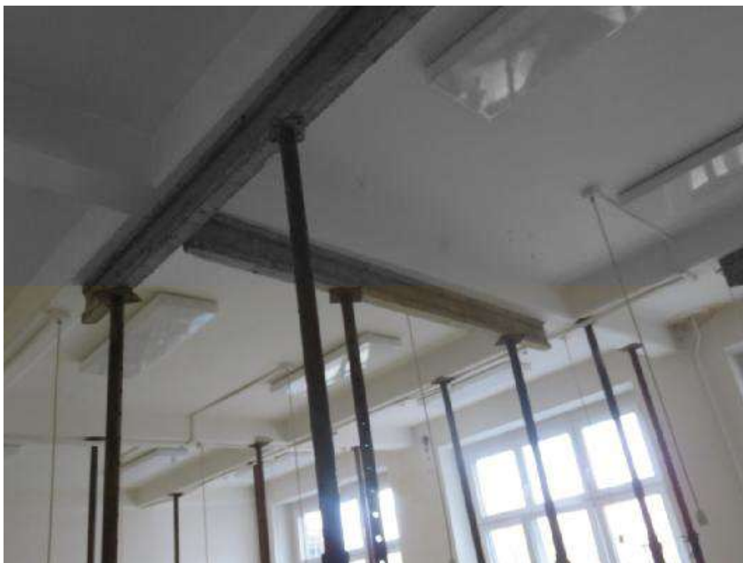
Foto 23: Hlavní budova 2.NP, místnost M1: viditelný průhyb stropní konstrukce cca 20 až 30 mm.
