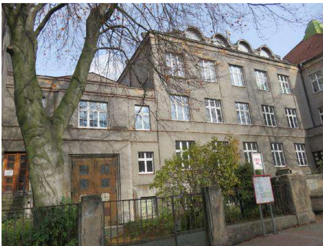
Foto 4: Jižní strana: pohled na jižní fasádu, na fasádě jsou patrné stopy po zatékání, degradace omítek zejména v oblasti atik.
