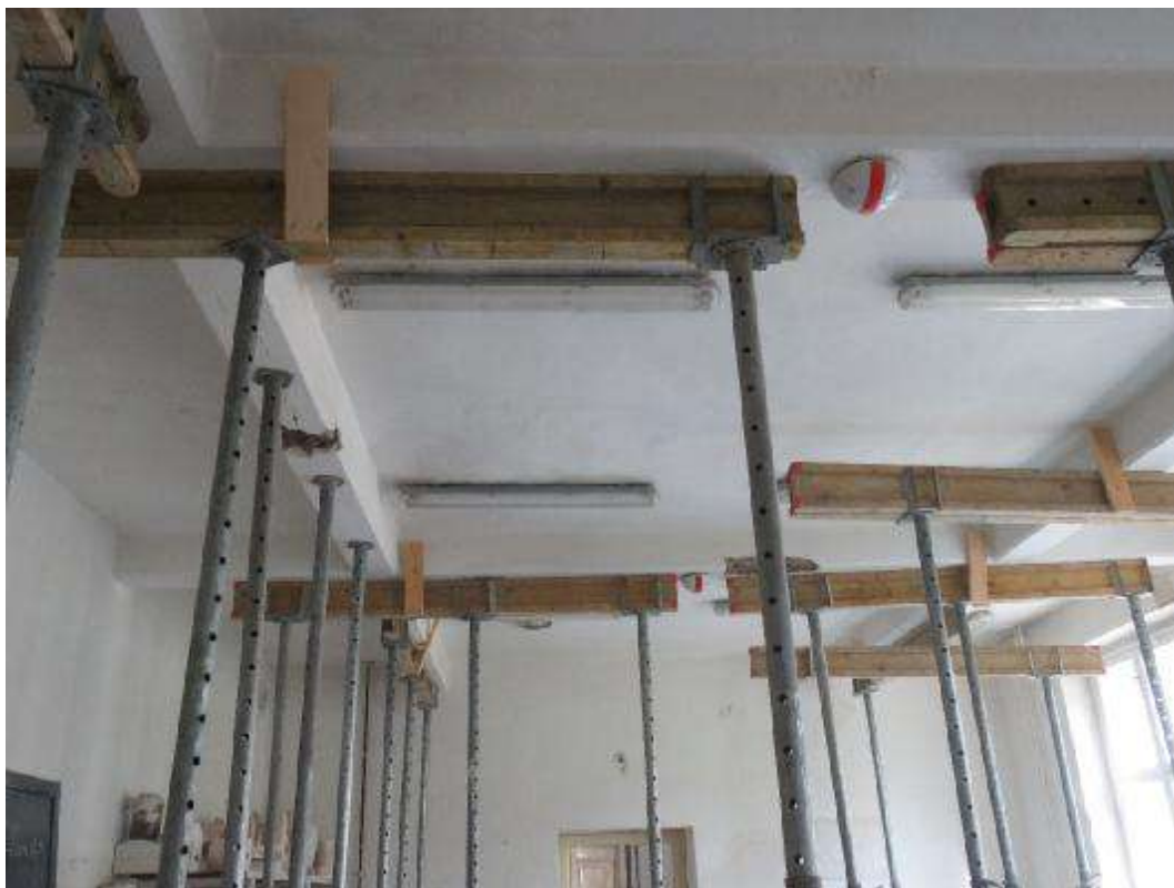
Foto 11: Hlavní budova 1.NP, místnost M2: viditelný průhyb stropní konstrukce cca 30 až 40 mm.
