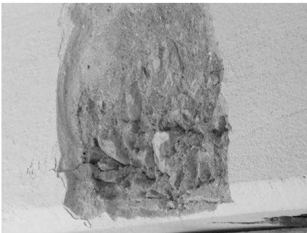
Foto 18: Hlavní budova 1.NP, místnost M2: trhliny na spodním líci středu tránu cca 3až4 mm. Trhliny oddělují krycí vrstvu betonu od výztuže.
