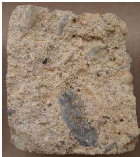
Foto 2: Vzorek betonu V 1.2
