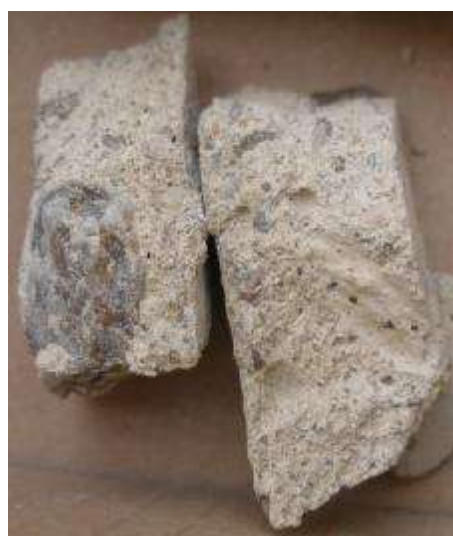
Foto 4: Vzorek betonu V 1.5
