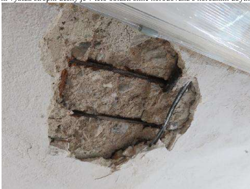
Foto 20: Hlavní budova 1.NP, místnost M2: v místě dlouhodobého zatékání z chemické laboratoře se odděluje krycí vrstva betonu, beton je v této oblasti silně degradován přes celou tloušťku stropní desky. Hlavní výztuž stropní desky je v této oblasti silně korodována s korozním úbytkem cca 30%.
