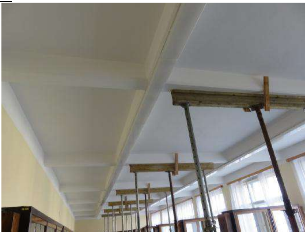
Foto 30: Hlavní budova 3.NP, místnost M1: viditelný průhyb stropní konstrukce cca 20 až 30 mm.
