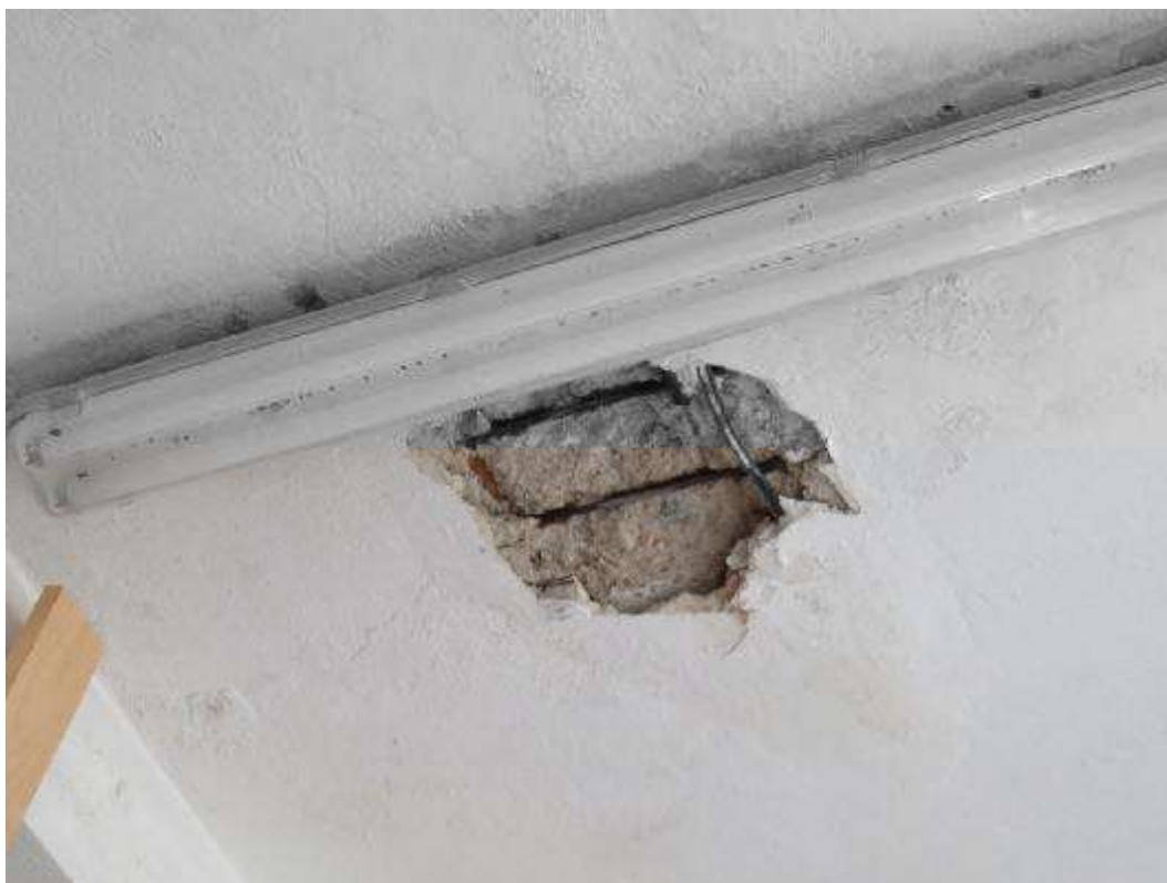
Foto 19: Hlavní budova 1.NP, místnost M2: v místě dlouhodobého zatékání z chemické laboratoře se odděluje krycí vrstva betonu, beton je v této oblasti silně degradován přes celou tloušťku stropní desky. Hlavní výztuž stropní desky je v této oblasti silně korodována s korozním úbytkem cca 30%.
