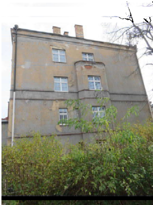
Foto 35: Západní strana: pohled na západní fasádu, na fasádě jsou patrné stopy po zatékání, degradace omítek zejména v oblasti atik a balkónu.
