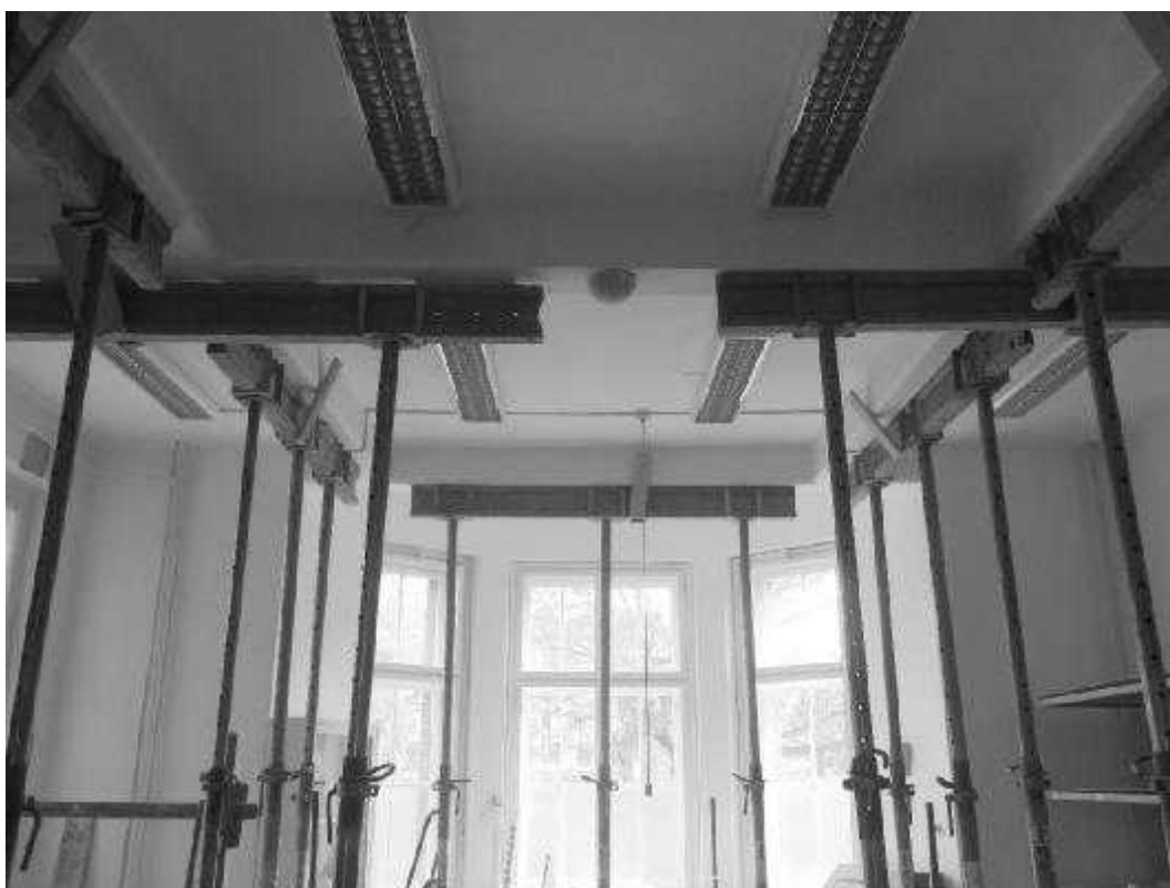
Foto 22: Hlavní budova 1.NP, místnost M3: viditelný průhyb stropní konstrukce cca 30 až 40 mm.
