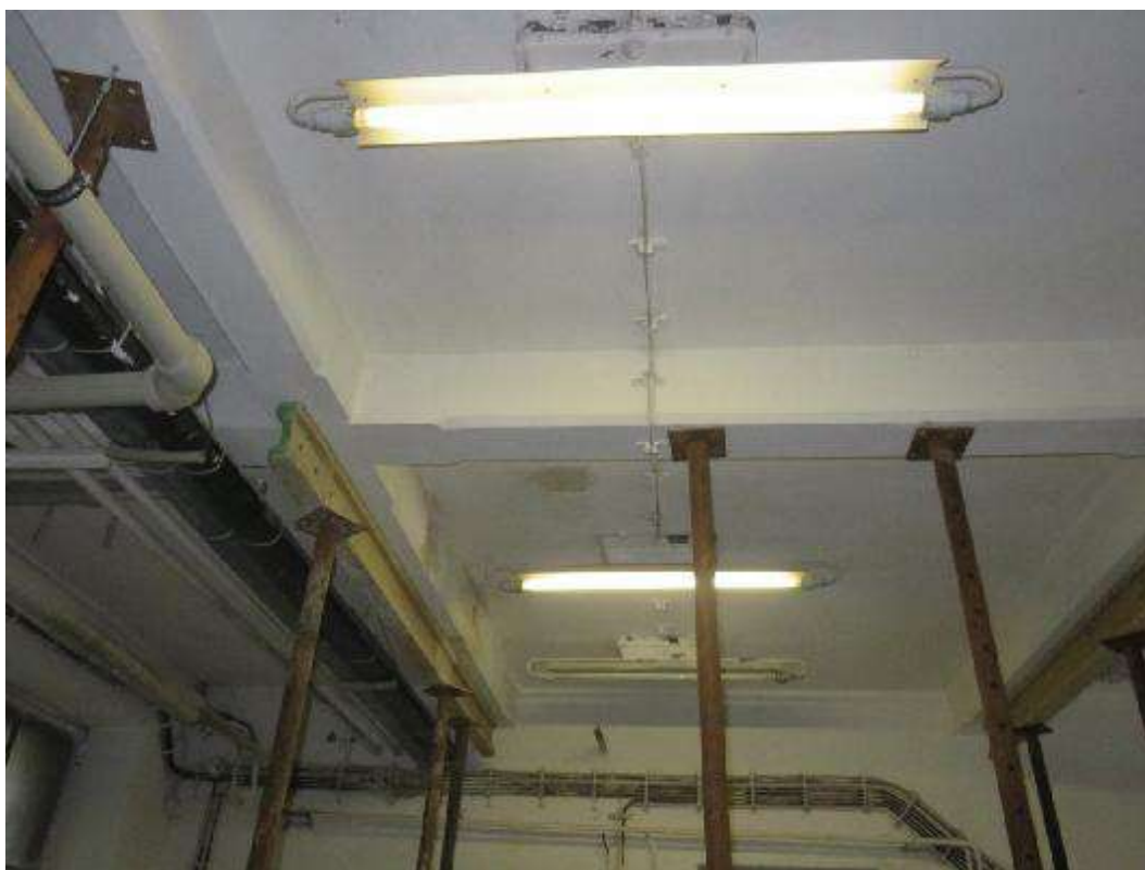
Foto 7: Hlavní budova 1.PP, místnost M1: viditelný průhyb stropní konstrukce cca 20 mm.
