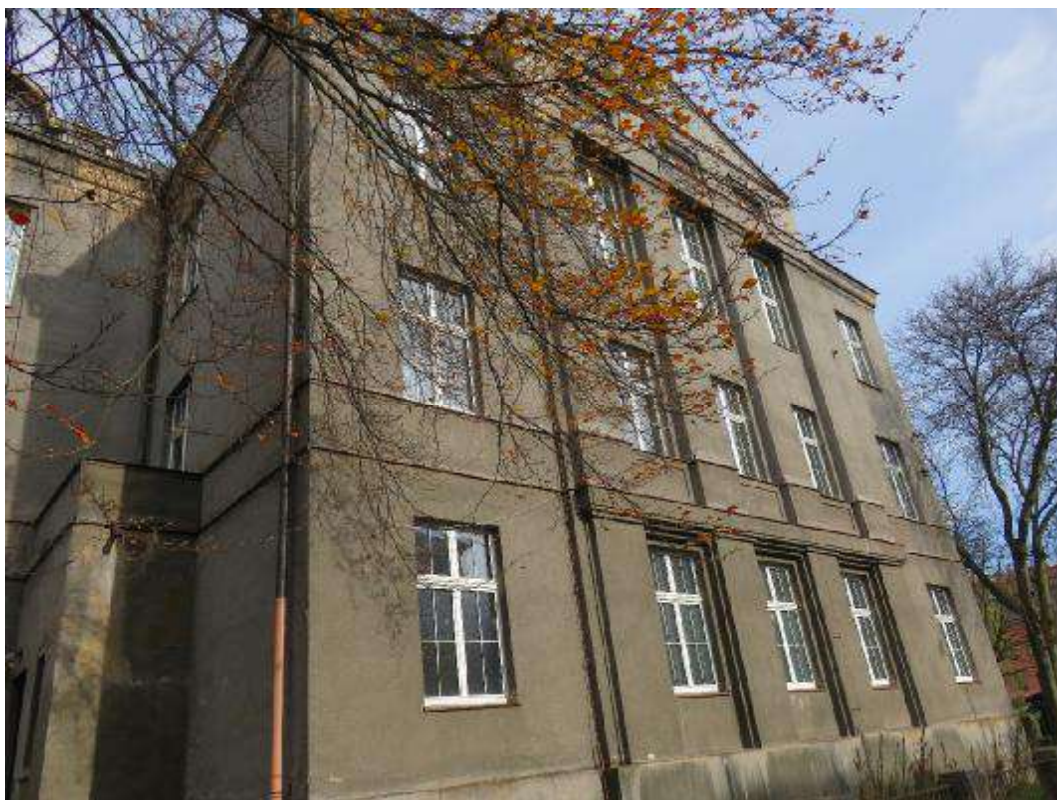
Foto 5: Jižní strana: pohled na jižní fasádu, na fasádě jsou patrné stopy po zatékání, degradace omítek zejména v oblasti atik.
