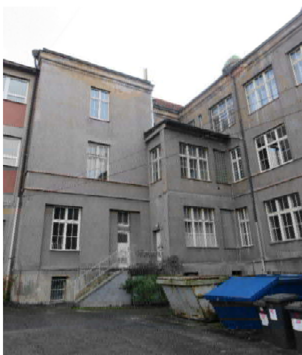
Foto 2: Západní strana: pohled na západní fasádu, na fasádě jsou patrné stopy po zatékání, degradace omítek zejména v oblasti atik.
