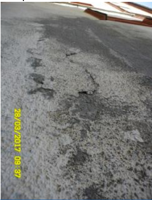
DETAIL PORUCHY FASÁDY
