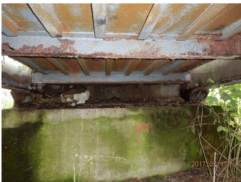
Pohled na opěru 1
