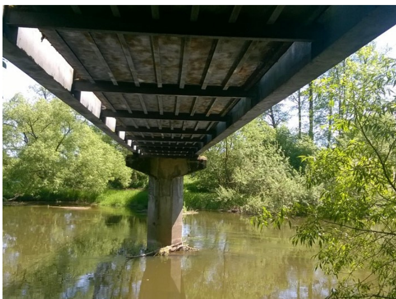
Pohled na pilíř 4 a podhled NK ve čtvrtém poli
