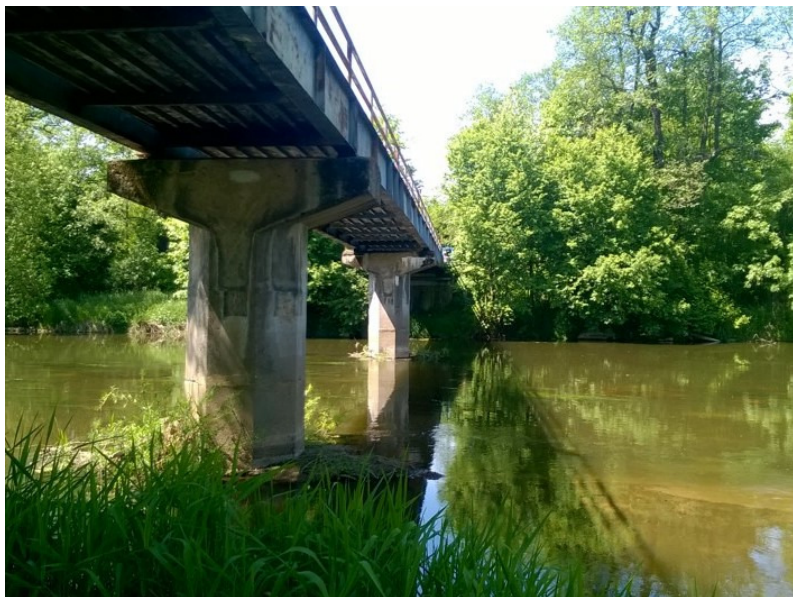
Boční pohled na most zprava
