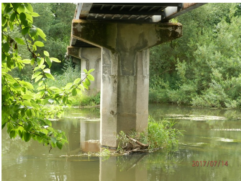
Pohled na pilíř 4
