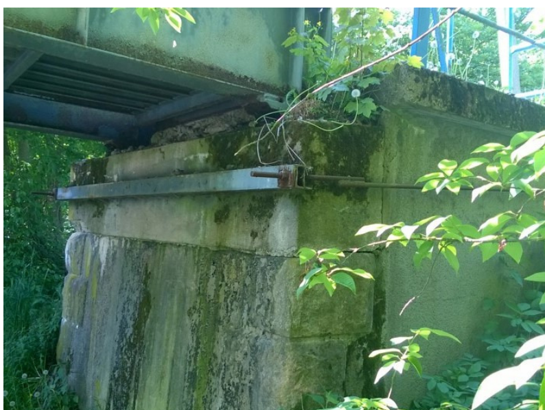
Pohled na opěru 5
