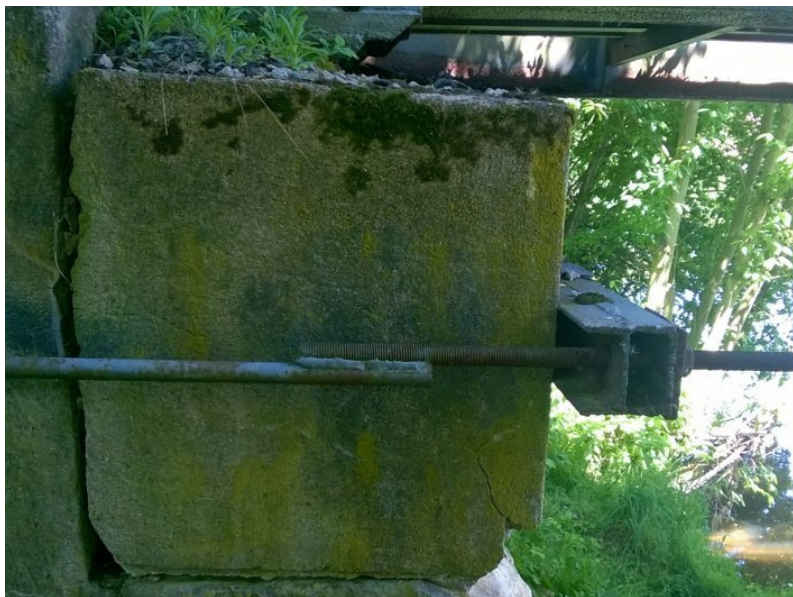
Zajištění uvolněných prahů na krajních opěrách
